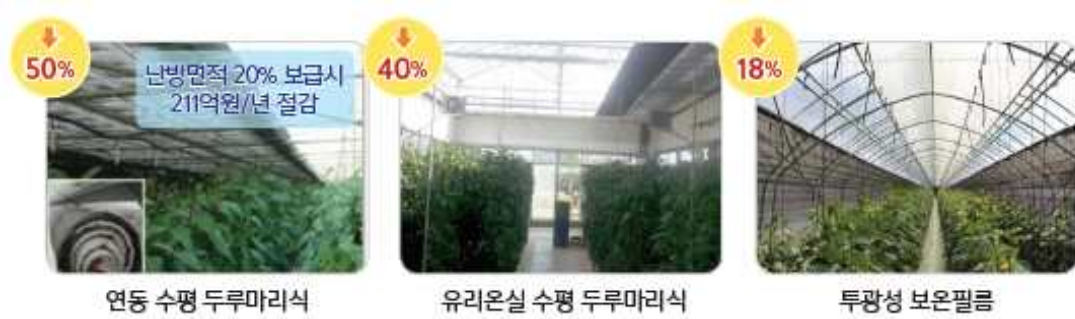
<그림 5-22> 다겹보온커튼 장치 설치
