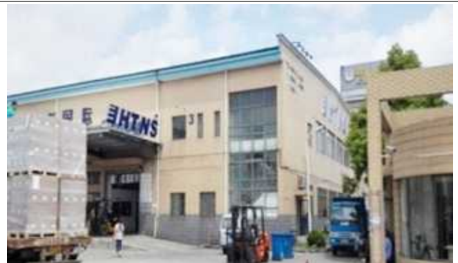
호치민 창고 전경
