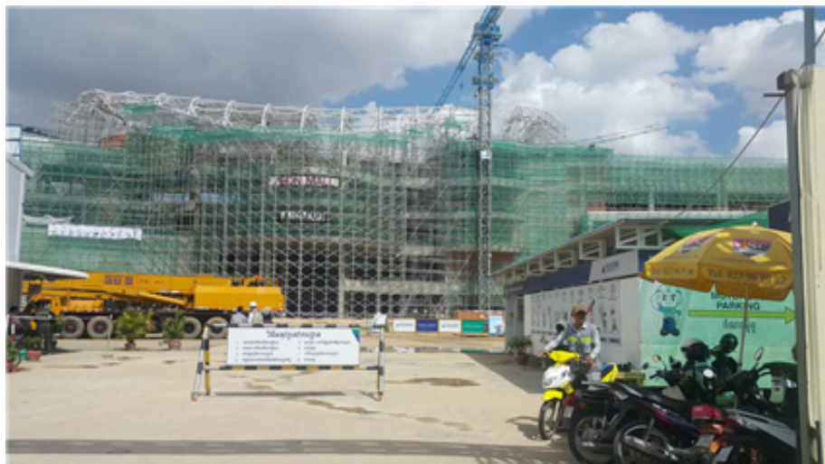
[그림] 프놈펜 외곽에 대규모로 신규 건설 중인 AEON Mall 2
