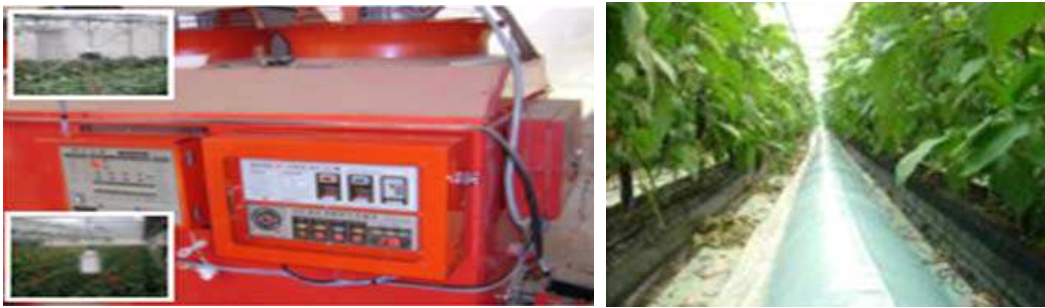
<그림 5-25> 일사 감응 변온관리장치(좌) 및 온풍난방기용 이중덕트(우)
