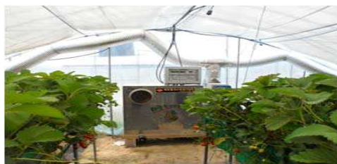
<그림 5-24> 열 회수형 환기장치(좌) 및 배기열 회수장치(우)
