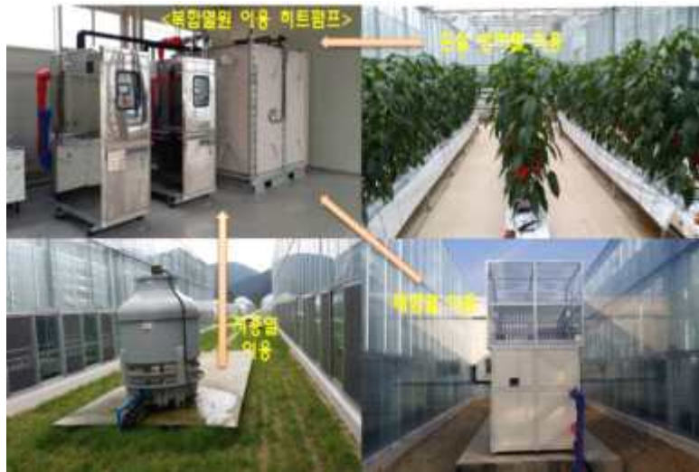
<그림 5-28> 복합열원을 이용한 온실 냉·난방
