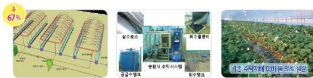
<그림 5-23> 단동하우스 순환식 수막시스템
