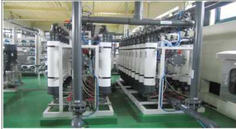
<그림 5-9> 채소용수 관개용 역삼투압 여과방식의 폐수처리 플랜트
