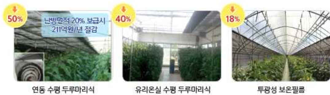
<그림 5-22> 다겹보온커튼 장치 설치
