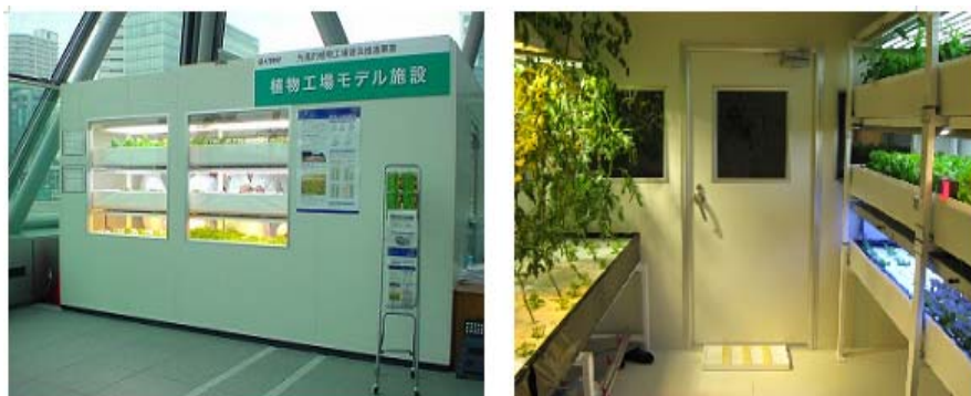
그림 6 경제산업성 별관 1층 로비에 설치된 식물공장
